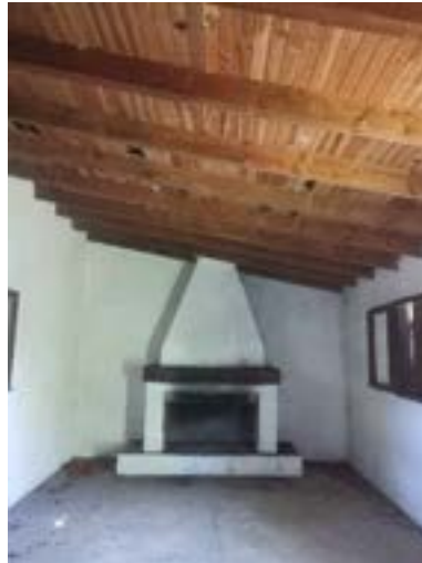
Photo 8. Trous au plafond pouvant servir de gîtes (© CEN Occitanie)
