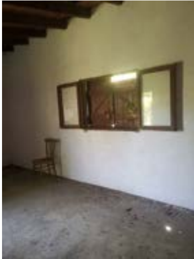
Photo 6. Potentielle entrée des chiroptères dans le bâti (© CEN Occitanie)
